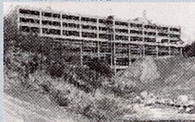
▼瀬戸の丘陵地に建設中の新学舎
