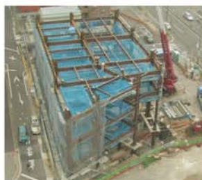
▲日比野学舎工事
